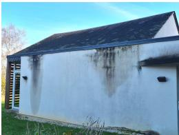
Les chéneaux (canaux posés sur le toit) de la salle de conseil vont aussi être réparés car les soudures ont cassé ce qui a marqué les murs du bâtiment.
